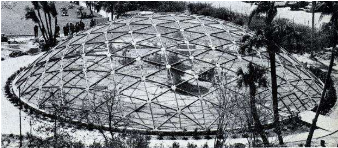
Fotografía No. 2. Estructura geodésica construida por Tank Car Company para el Aviario de Busch Gardens, Tampa Estados Unidos en 1954. Tomado de Fuller y Marks (1963).
