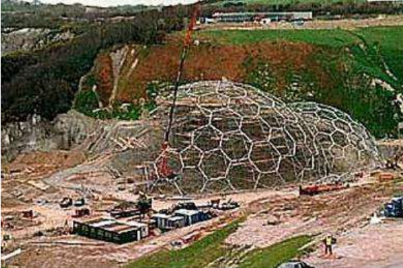
Fotografía No. 8. Construcción de las estructuras de acero. Tomado de Harris (s.f.)
