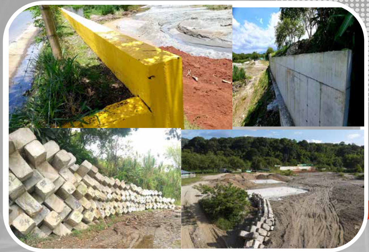
Proceso constructivo de las actividades de manejo del cauce
