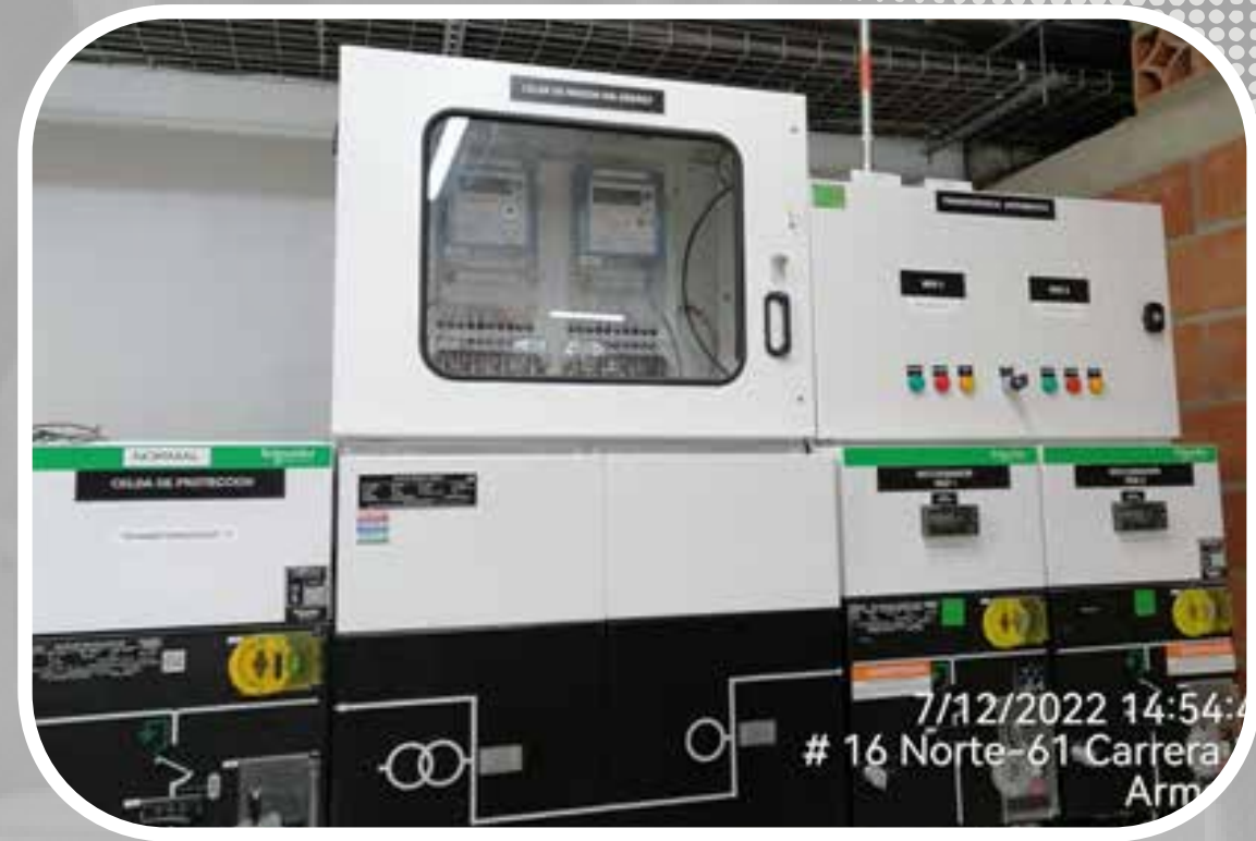
Equipos subestación Eléctrica
