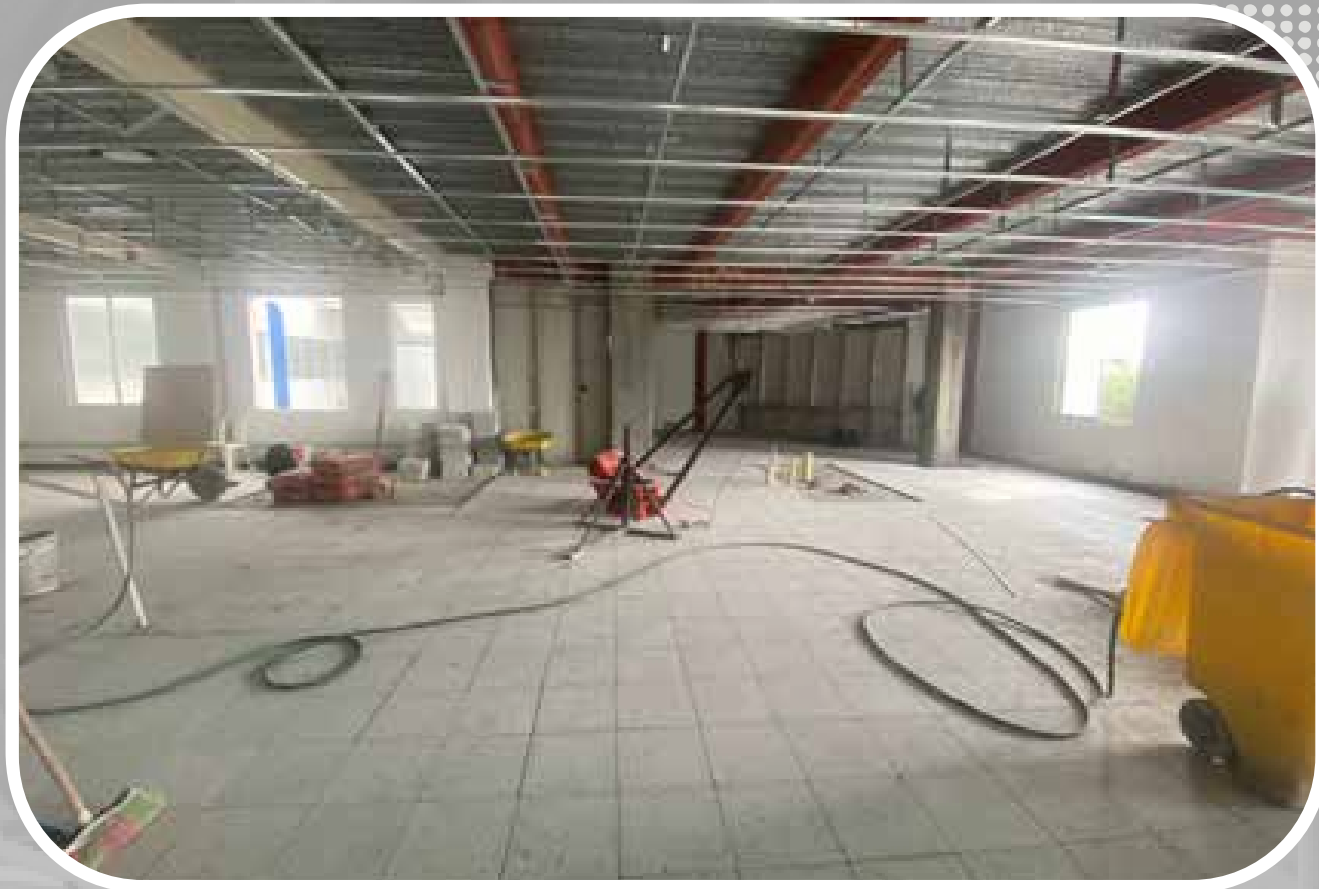
Zona 1 espacio en obra negra para la adecuación de 21 camas hospitalarias para el tratamiento de espacios COVID-19
