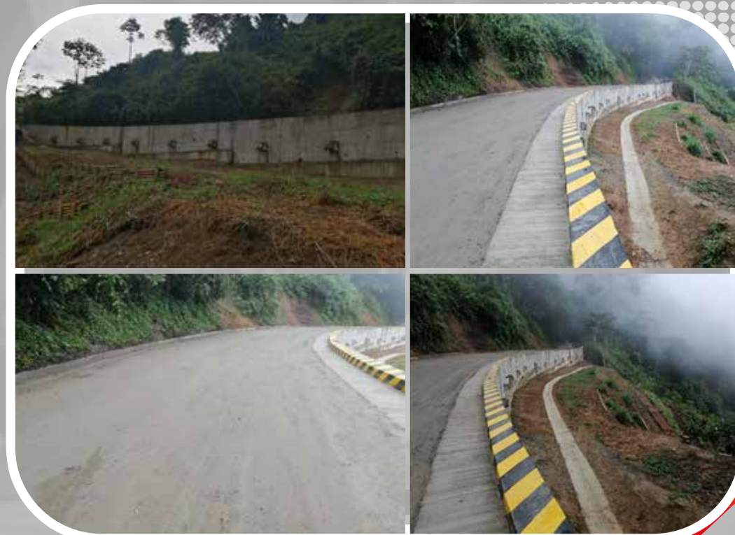
Obras de estabilización y rehabilitación de la vía terminada
