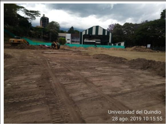
Ilustración 50 excavación a máquina pista y cancha. Universidad del Quindío.
