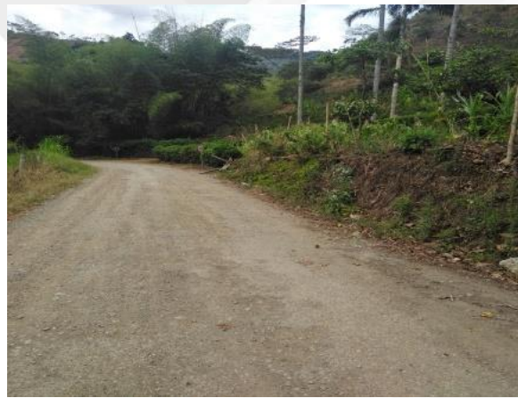
Ilustración 65 Tramo vía a Rehabilitar Fil la india 2
