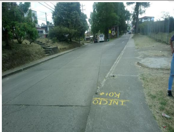
Ilustración 52 Estado actual de la vía 1, Circasia - Montenegro.
