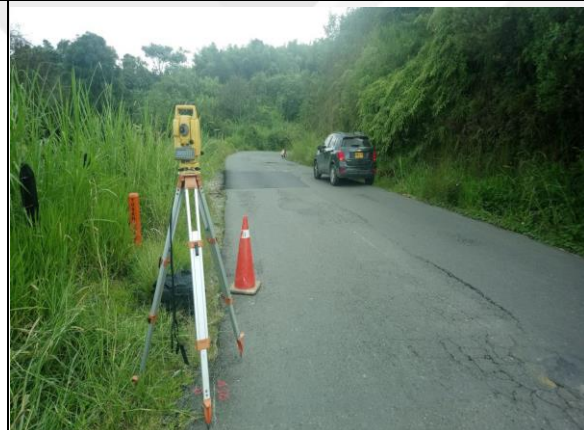
Ilustración 53 Estado actual de la vía 2, Circasia - Montenegro.
