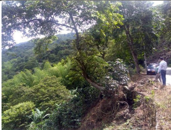
Ilustración 70 Estado de la vía K19+400.
