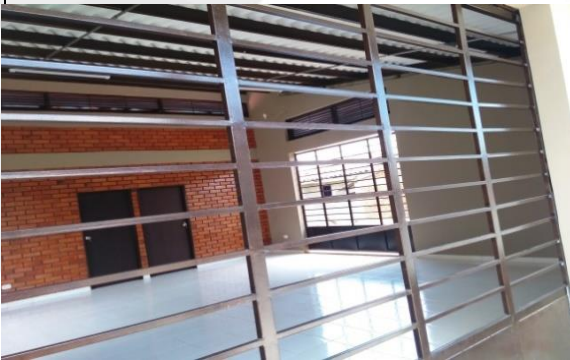
Ilustración 19 Detalle al interior del salón social de la ciudadela el ensueño Mpio de Quimbaya.
