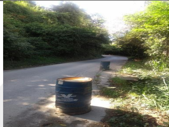
Ilustración 71 Estado de la vía K3+400.
