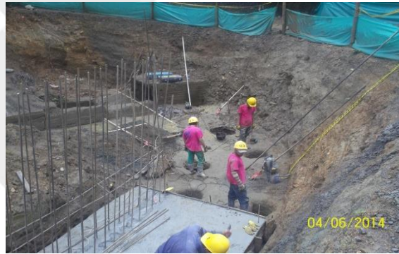
Ilustración 7 Proceso constructivo muro Municipio de Buenavista.
