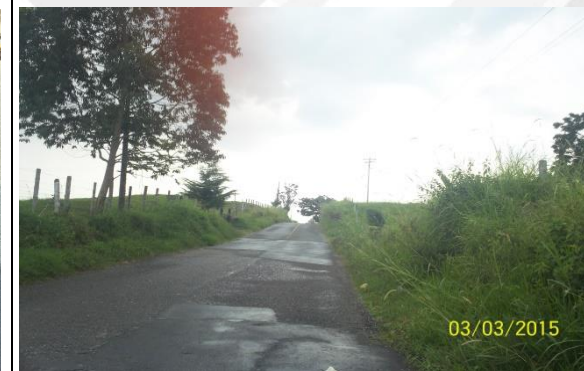
Ilustración 12 reparcho punto crítico circasia-Montenegro.
