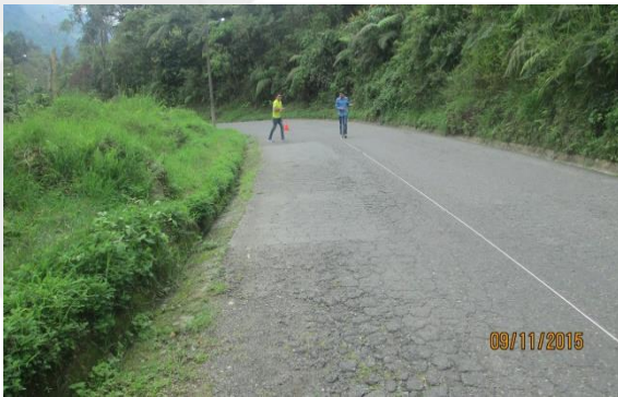
Ilustración 23 tramo pijao: selección del área a intervenir por desgaste de la superficie de rodadura.
