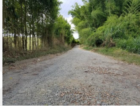
Ilustración 32 Tramo 1 - Estado Actual Vía, Vereda la Morelia Mpio de Quimbaya.
