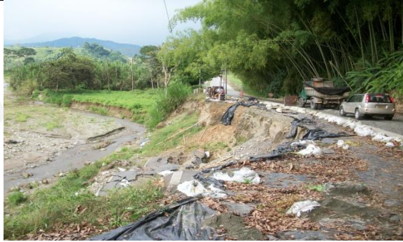
Ilustración 1 Estado de la vía Rio Verde - Barragán.
