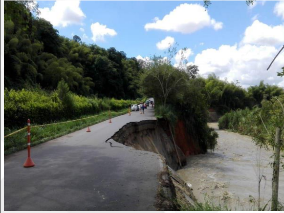
Ilustración 57 Lugar de estabilización, punto crítico K12:850 vía que conduce de la vereda la española, rio verde, barragán.
