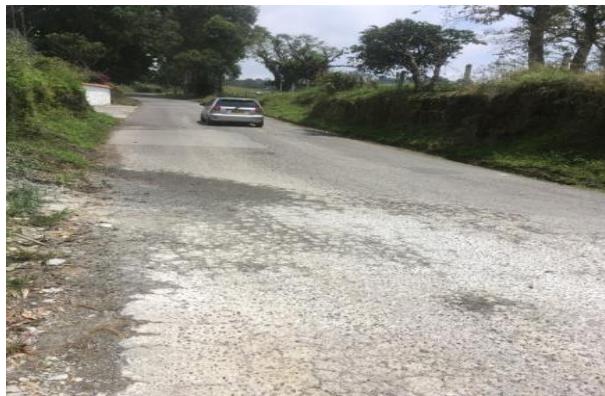
Ilustración 66 Tramo vía a Rehabilitar Fil la india
