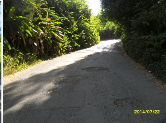
Ilustración 10 Estado inicial del proyecto, vía terciaria Municipio de Quimbaya.
