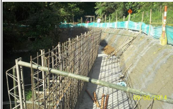
Ilustración 8 Muro y obras de disipación Municipio de Buenavista.
