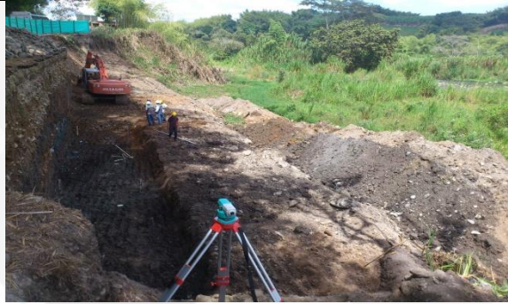
Ilustración 2 Localización y Replanteo para la construcción.
