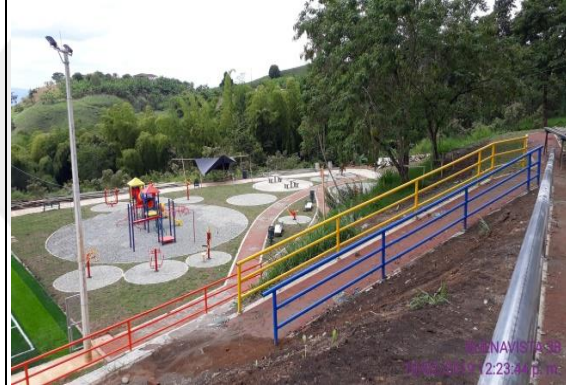
Ilustración 39 Ejecución Parque Mpio de Buenavista.
