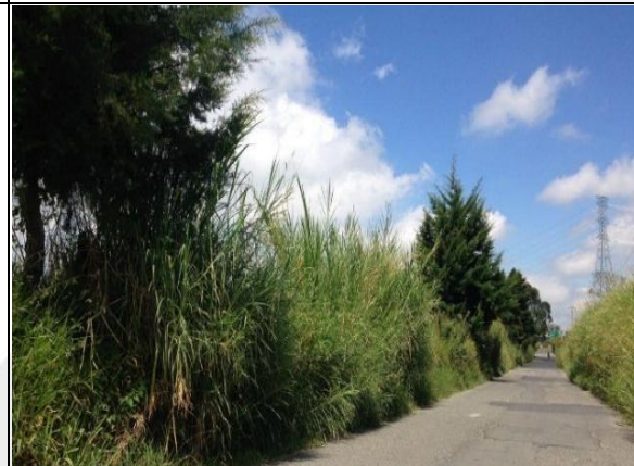
Ilustración 55 Estado actual de la vía 4, Circasia - Montenegro.
