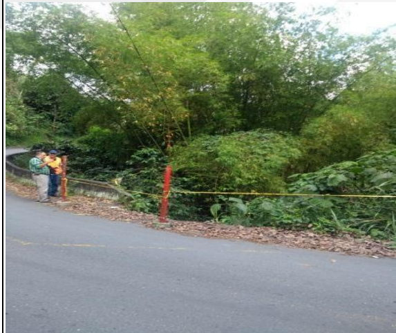
Ilustración 69 Estado de la vía K10+500
