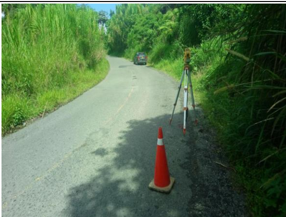
Ilustración 54 Estado actual de la vía 3, Circasia - Montenegro.
