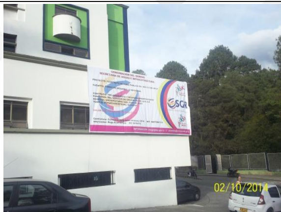
Ilustración 24 Instalación de Valla al inicio de la obra, Hospital San Juan de Dios.
