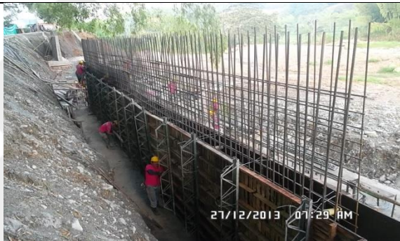
Ilustración 3 Construcción muro estabilización.
