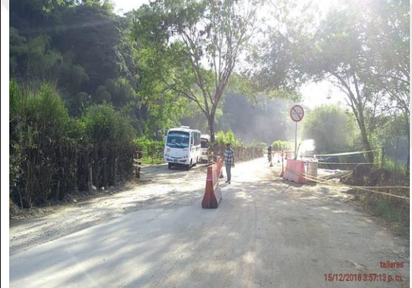
Ilustración 59 Manejo de transito 2, punto crítico K12:850 vía que conduce de la vereda la española, rio verde, barragán.
