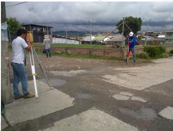
Ilustración 13 Localización y replanteo, proyecto CAD de Filandia.
