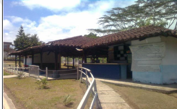
Ilustración 20 Estado de los salones antes de iniciar la obra, barrio Ahitamara Mpio de Armenia.
