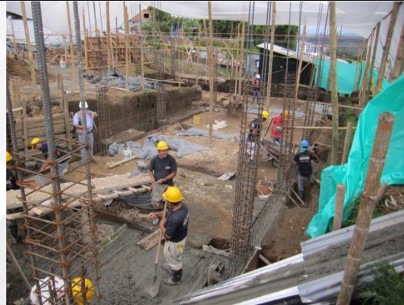
Ilustración 14 Estructura, Fundición de cimentación, proyecto CAD de Filandia.
