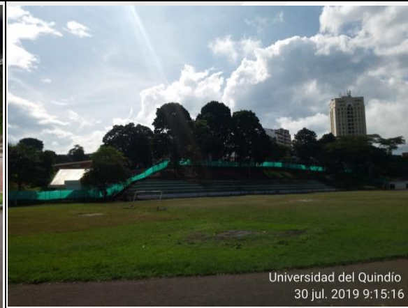
Ilustración 49 Estado inicial del proyecto Cancha y pista de la Universidad del Quindío.
