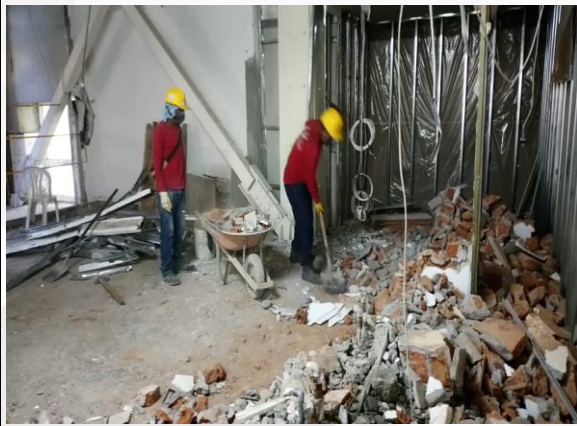
Ilustración 45 Remodelación del Hospital San Juan de Dios Mpio de Armenia.
