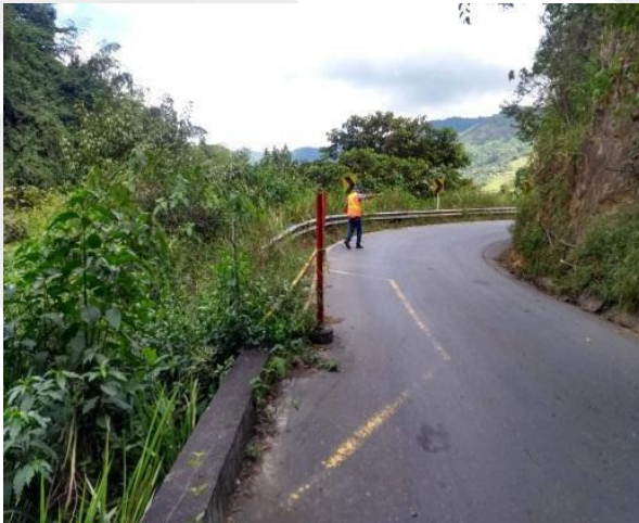
Ilustración 68 Estado de la vía K11+600
