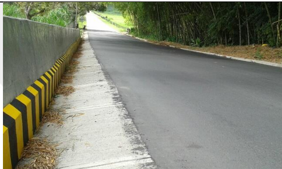
Ilustración 4 Rehabilitación vía terminada.
