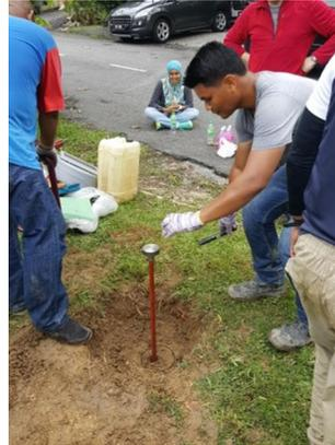
*Figura 45. Cabezal de manejo incorporada a la parte superior del tubo de acero para ayudar a conducirlo*
