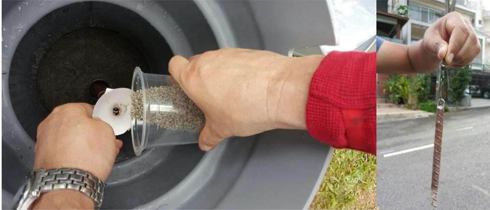
Figura 47. Relleno (arena en este caso) colocado dentro de la guía de ondas en capas nominales de 0,25 m y compactados usando un peso en una cuerda delgada.
