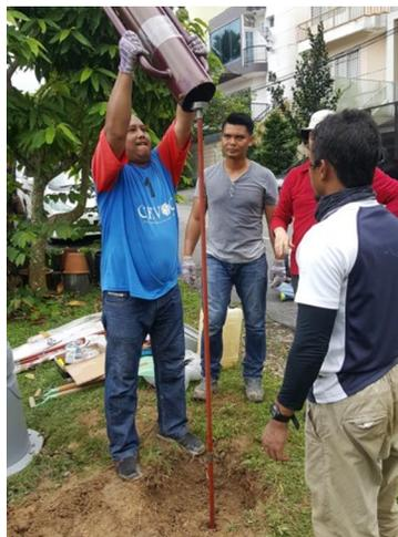
*Figura 46. Uso de una apisonadora de estacas para conducir la guía de ondas*
