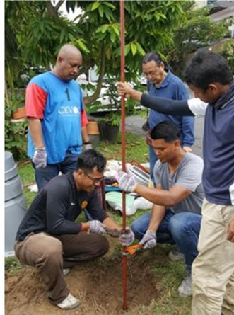
*Figura 43. Conexión de los tubos utilizando una llave inglesa para apretar los extremos roscados en un acoplamiento
