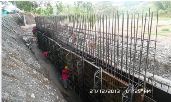
Ilustración 3 Construcción muro estabilización.
