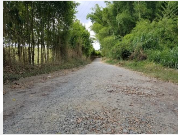
Ilustración 32 Tramo 1 - Estado Actual Vía, Vereda la Morelia Mpio de Quimbaya.
