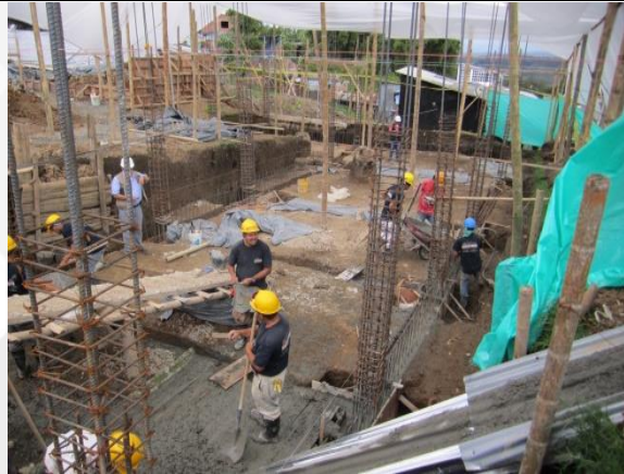
Ilustración 14 Estructura, Fundición de cimentación, proyecto CAD de Filandia.
