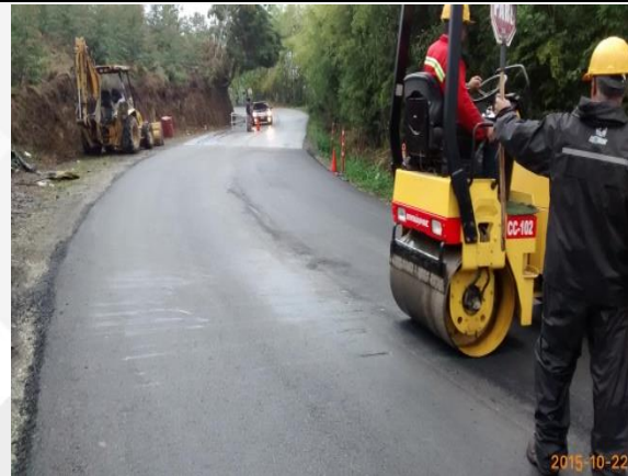
Ilustración 22 Tramo Salento: reparación tramo, maquinaria empleada y medidas de prevención - señalización.
