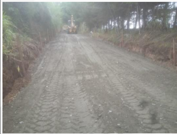
Ilustración 35 Tramo inicial, Sector Buenavista Municipio de Circasia.
