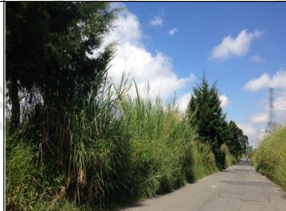
Ilustración 55 Estado actual de la vía 4, Circasia - Montenegro.
