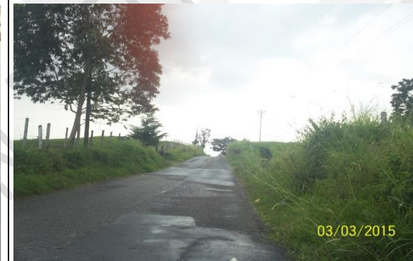
Ilustración 12 reparcho punto crítico circasia-Montenegro.
