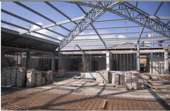
Ilustración 15 Estructura metálica, proyecto CAD de Filandia.
