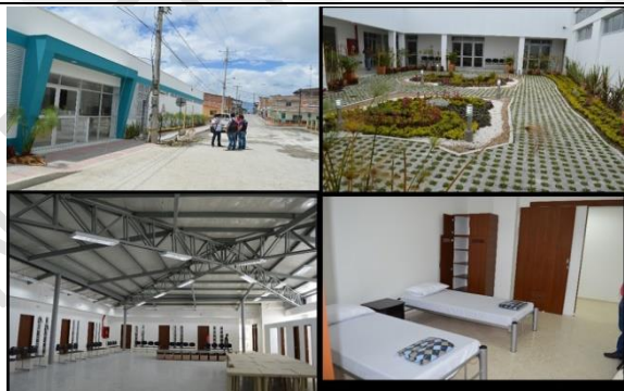
Ilustración 16 Proyecto finalizado, Centro de Atención y Drogadicción de Filandia.
