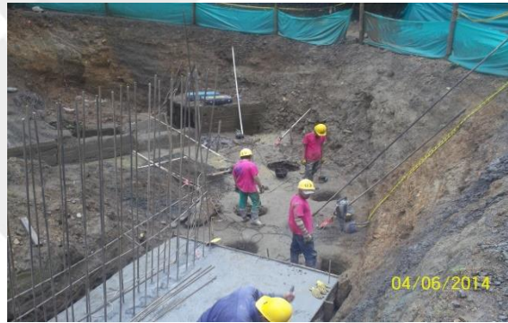
Ilustración 7 Proceso constructivo muro Municipio de Buenavista.
