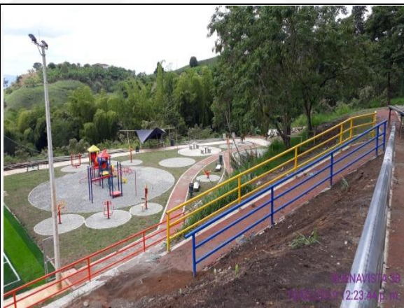
Ilustración 39 Ejecución Parque Mpio de Buenavista.
