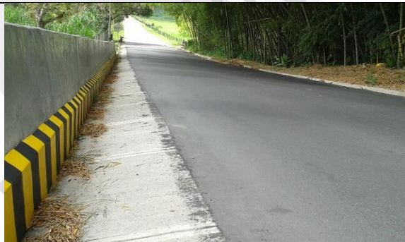
Ilustración 4 Rehabilitación vía terminada.
